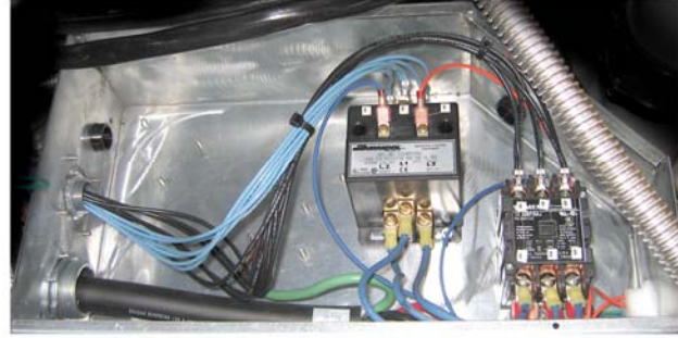
Mekaanisen kontaktorilaatikon komponentit vasemmalta ja oikealta katsottuna.
